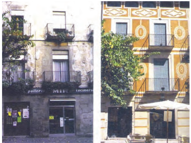
Fig. 199 - Girona antes da transformação da cidade na década de 1980 Fig. 200 e 201 - Imóvel antes e depois da requalificação | Fonte: Girona, 20 anys del Pla Especial del Barri Vell 1983-2003
